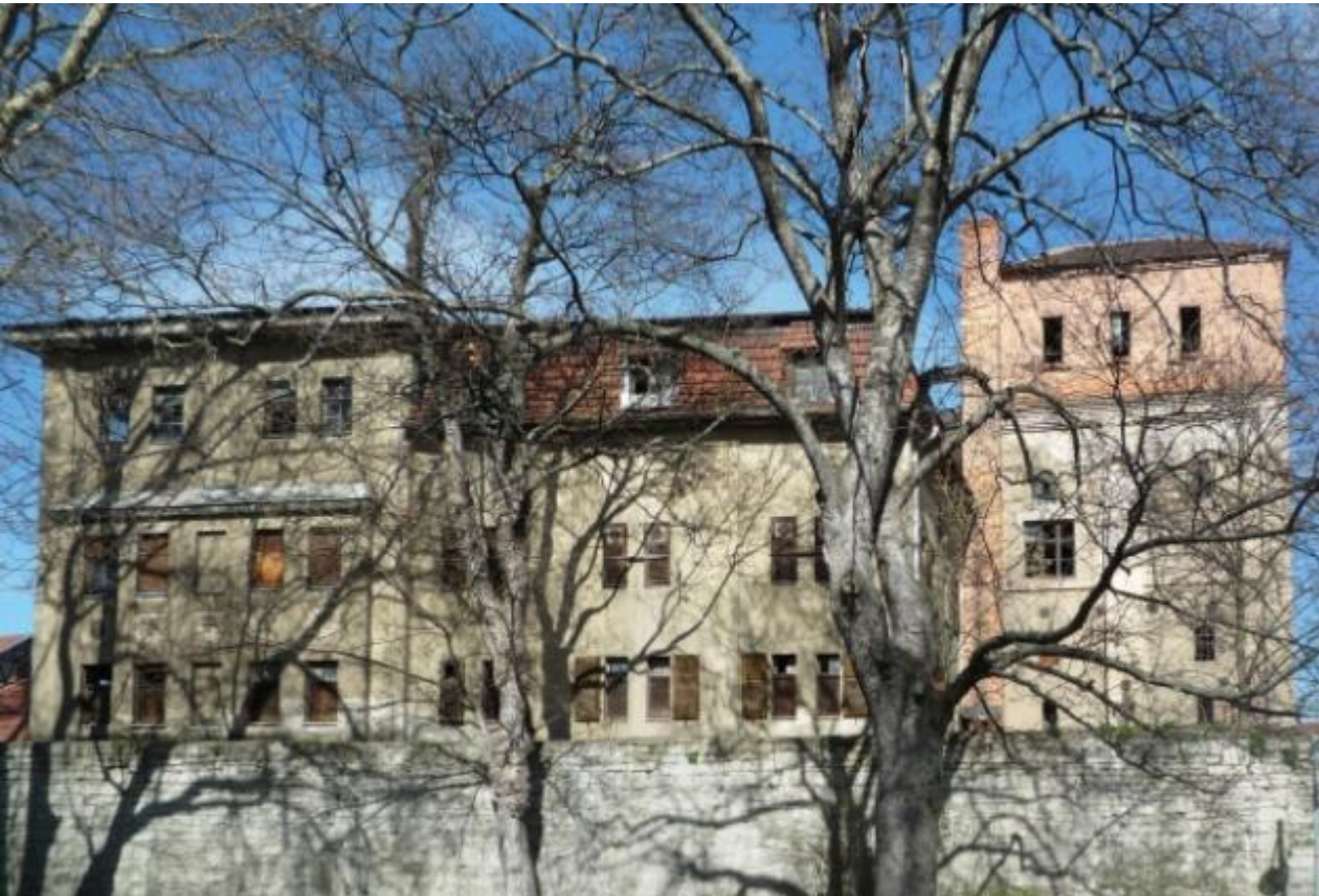
Ansicht von der Stadtmauer
